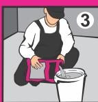
Для подготовки раствора высыпьте мешок полностью в чистую ёмкость, объёмом не менее 90 л. После этого залейте чистую водопроводную воду из расчёта 7 л на один мешок (11,5 кг).
